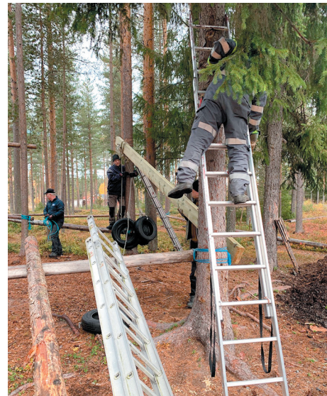
Arbeten vid Äventyrsbanan
