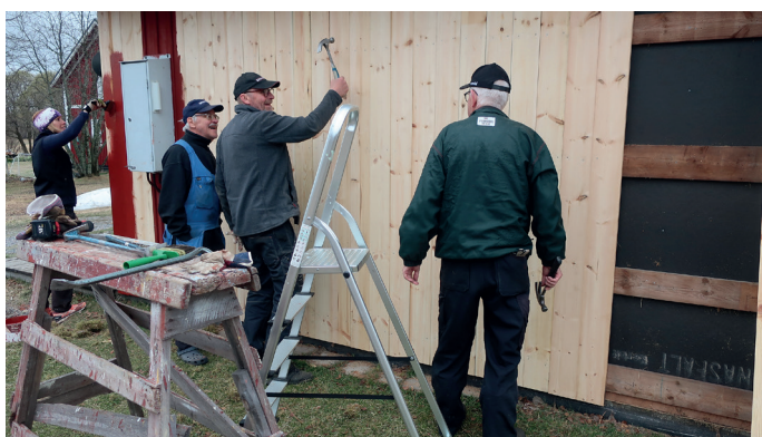
På bilden ses Karin Sandström, Helge Björnström, Bo Axhammar och Hans Blomqvist arbeta med ena väggen.
