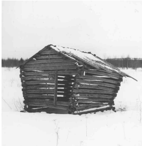
Ganska många lador hade dörren på gavelns ena sida, inte på mitten.
