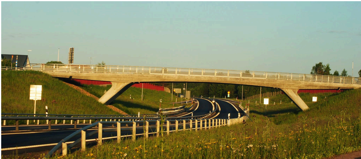
Bron över E4:an har gjort trafikmiljön mellan bydelarna säkrare. Foto: Stefan Ericson
