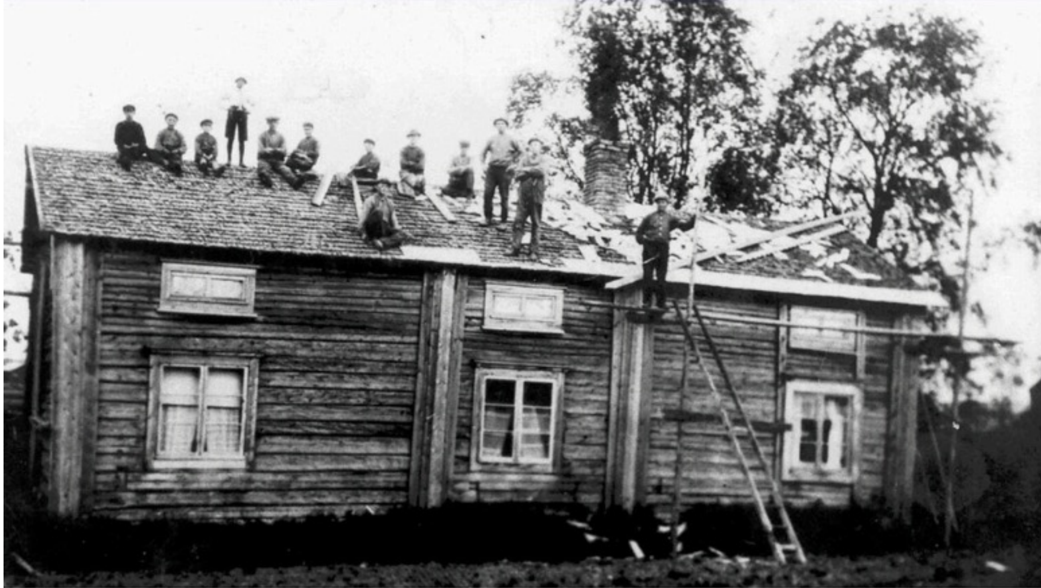
Läggning av nytt sticktak på fd. "Baronsgården" Ersnäs. Foto i början av 1920 -talet av Lotten Eklund Luleå.
