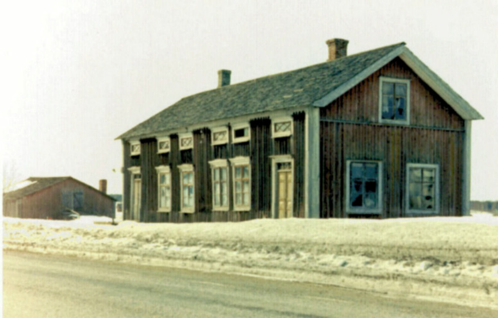
Ersnäs gamla gästgiveri " Moppas". Äg. bröderna Zakrisson Ersnäs. Foto Folke Larsson 1966-04. Huset revs hösten samma år pga.vägarb.
