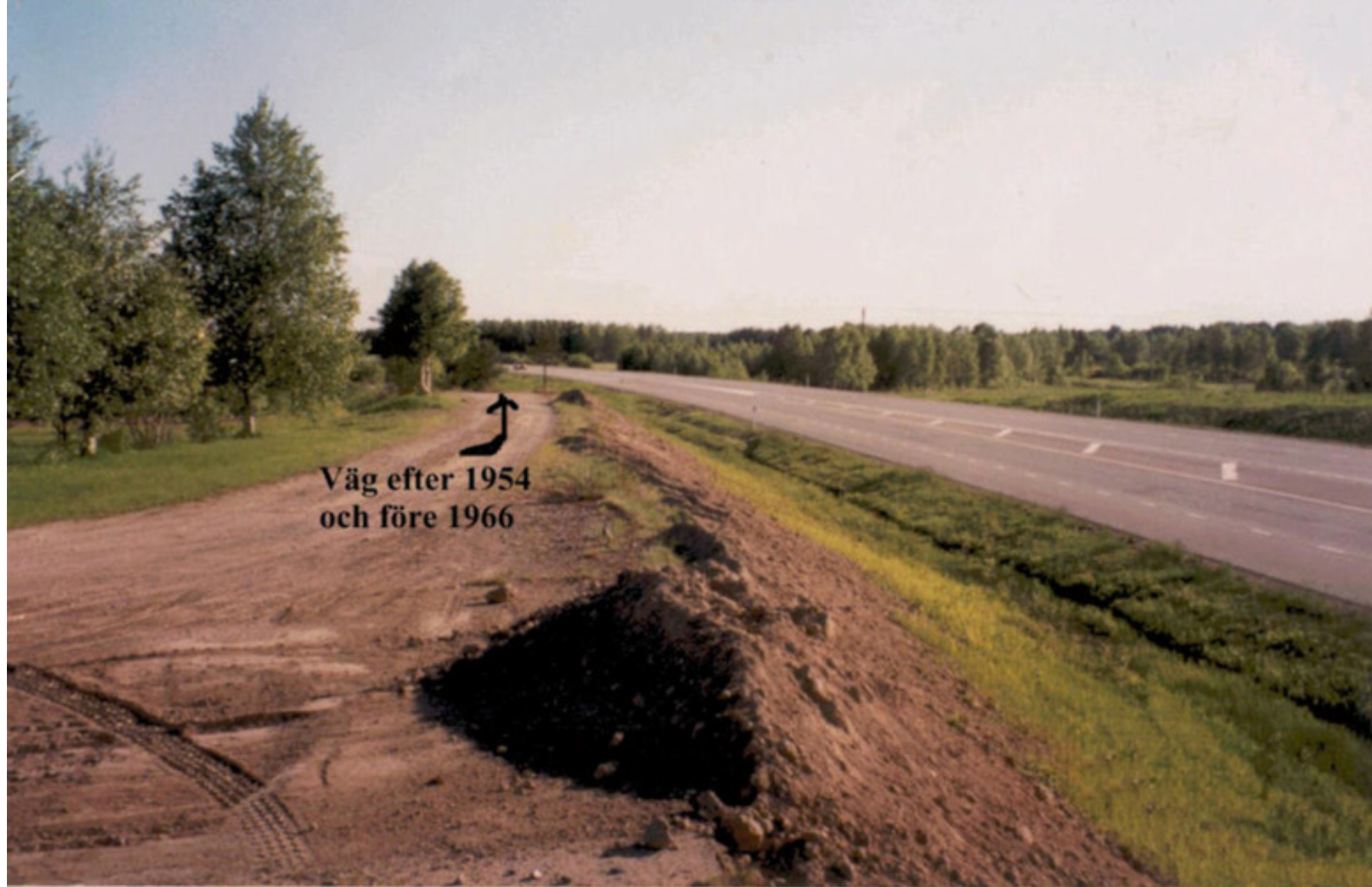
Ersnäs E4 (Fd. Riks 13) mot söder från dåv. N. korsningen. Foto Folke Larsson 1999. Data-bild-text dito 2002.
