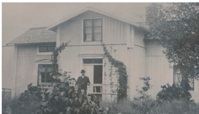
Skräddar-Åströms - Klubbvägen 126, ägare Leif Lundström. Skräddaren August Åström står på bron. Bilden tagen 1917 eller tidigare.
